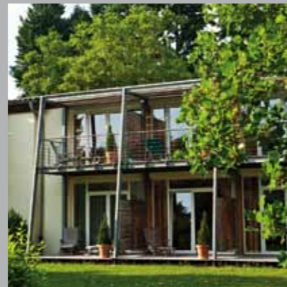
Südhaus | Moderne, sonnige Südzimmer (Parterre und 1. Etage) mit Loggia oder Balkon und Blick in den Park; direkter Zugang zu Gymnastikhalle und Therapieabteilung
